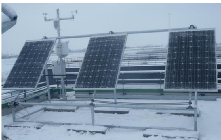
Сурет 1.27 – Өзара тізбектей қосылған бір осьті күнді бақылау жүйесі [45]
